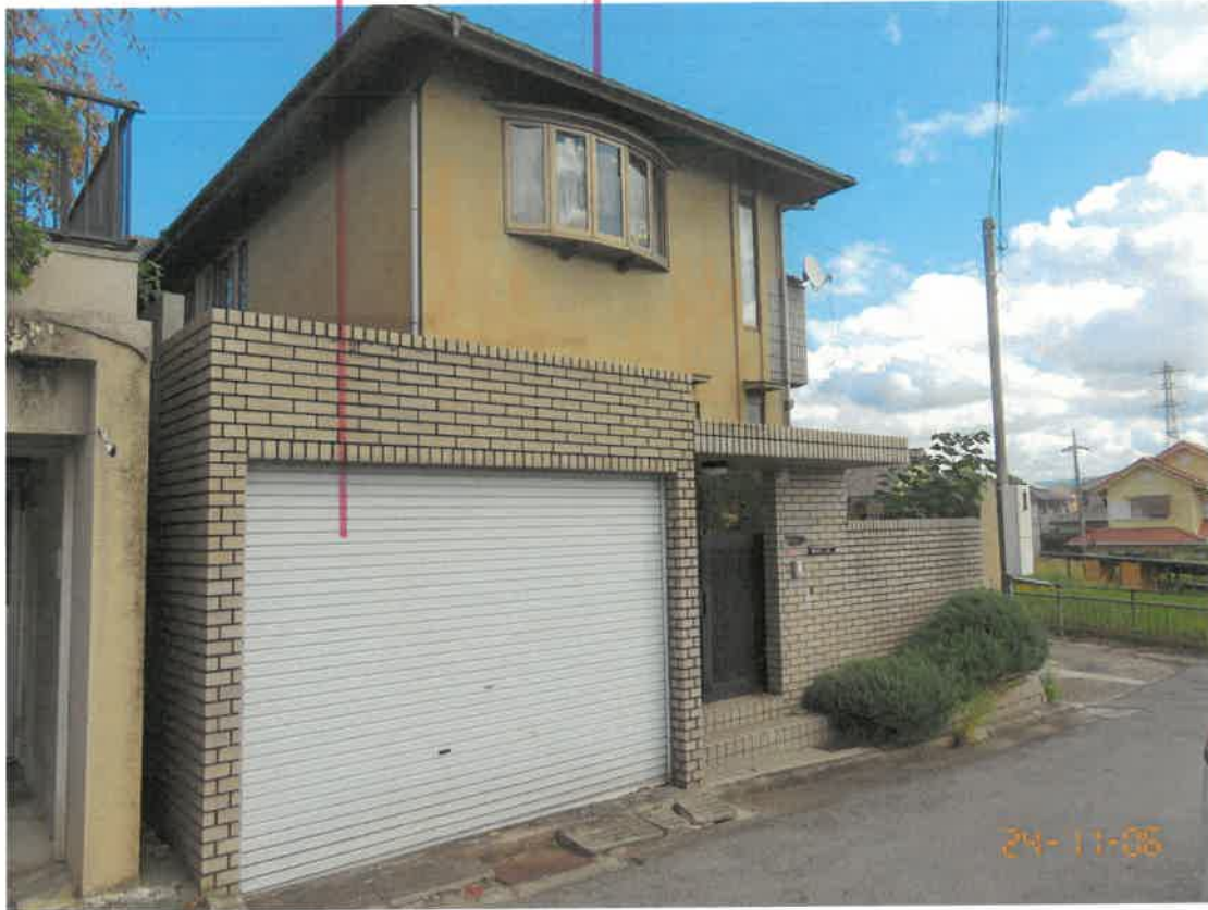
カーポートのシャッター 目的建物
