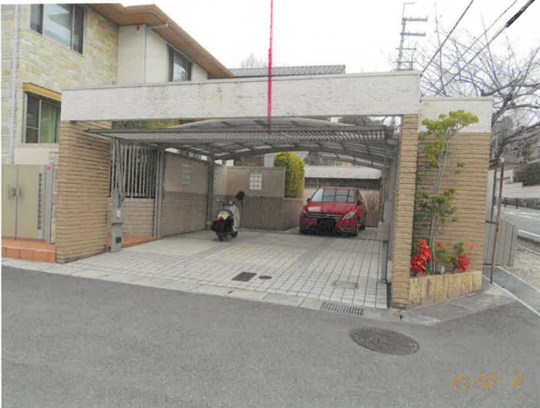
カーポートの状況
