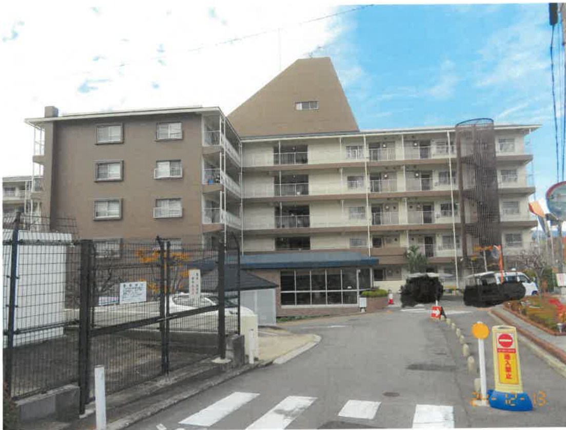
一棟の建物全景
