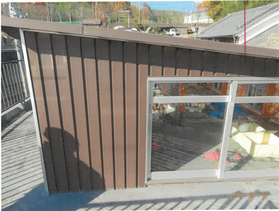
目的外建物(主である建物)陸屋根部分に存在した工作物
