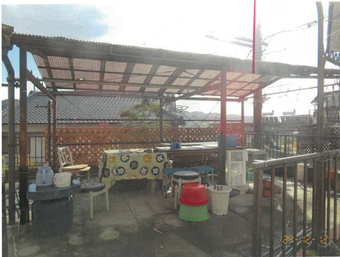
目的外建物(附属建物)上部に存在した上屋
