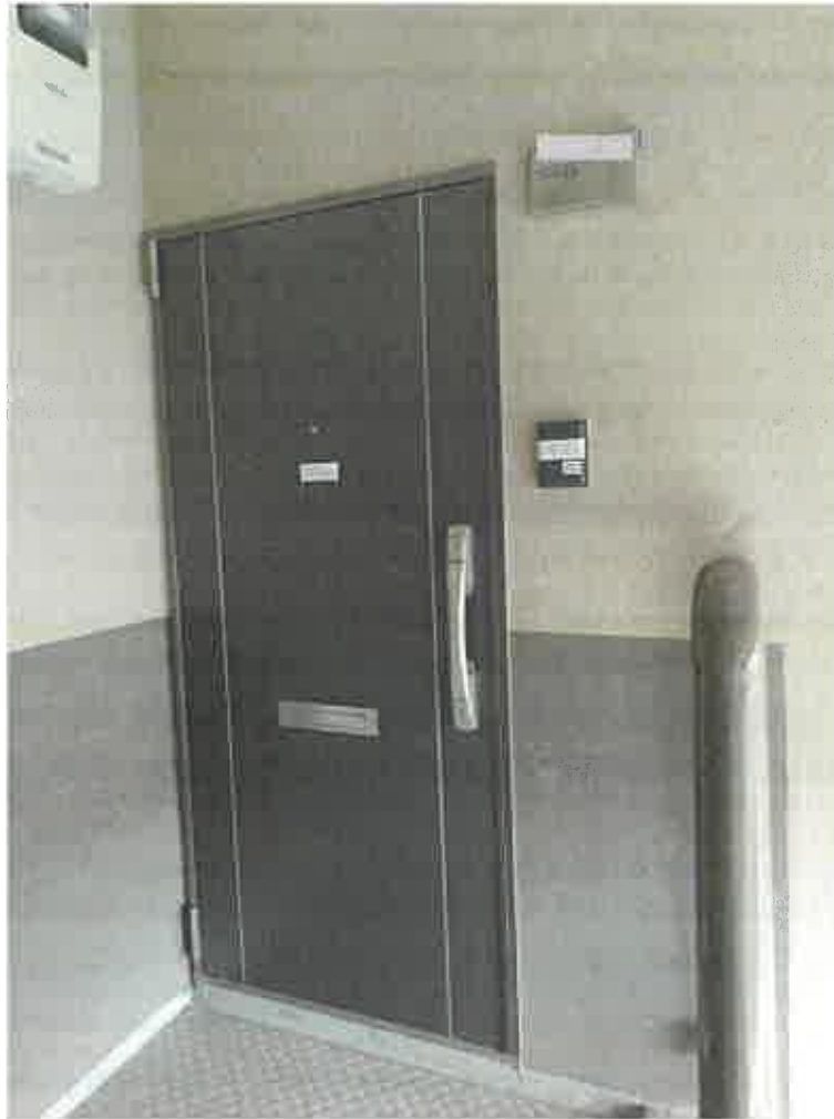
専有部分玄関付近
