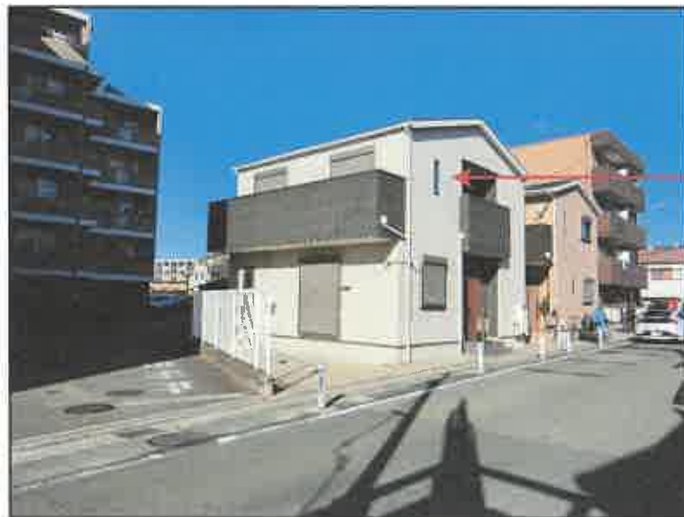
物件 2 の建物 対象物件を 南東方から撮影
