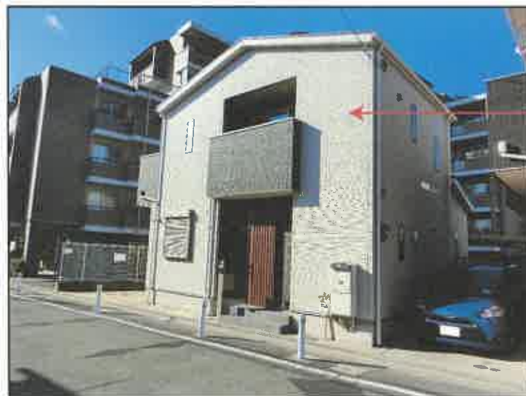
物件 2 の建物 対象物件を 北東方から撮影
