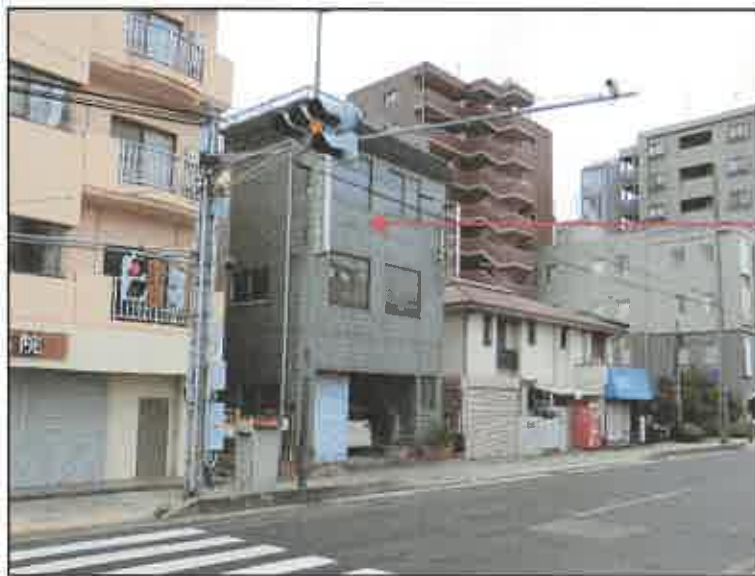
物件 2 の建物 対象物件を 北東方から撮影
