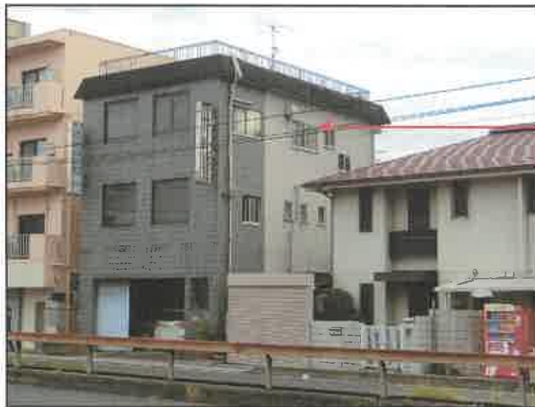
物件 2 の建物 対象物件を 北西方から撮影
