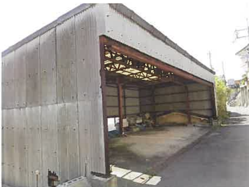
北西側道路より
