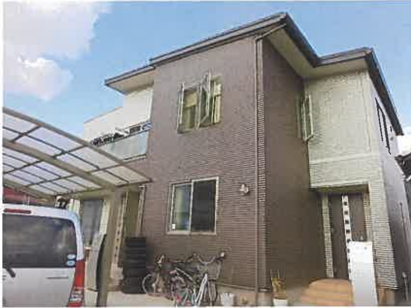
物件2 南側より
