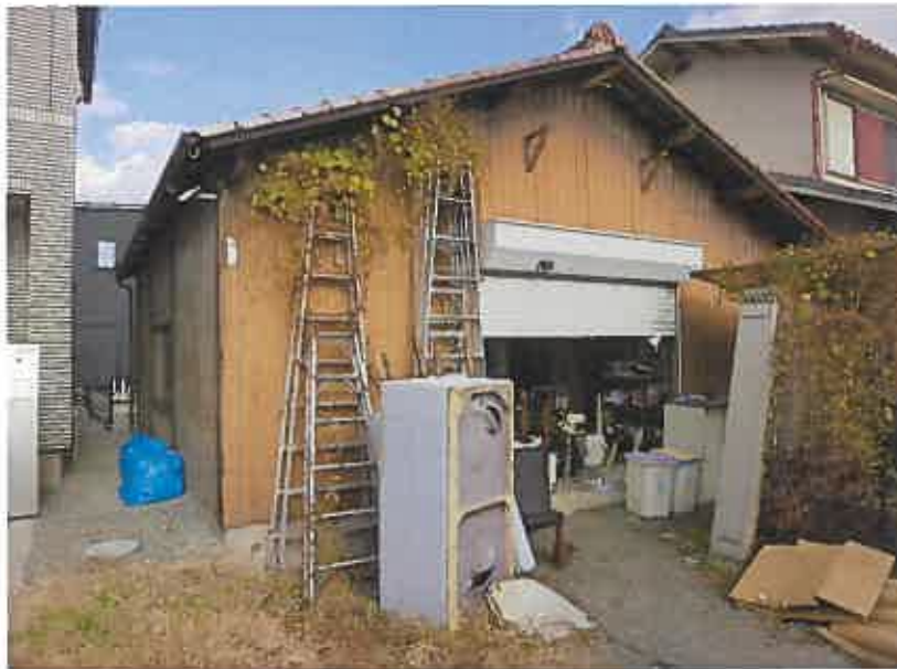
物件3 南側より
