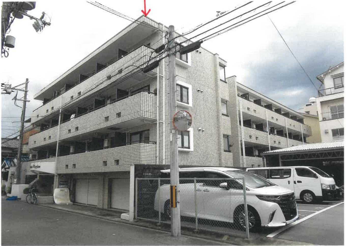
物件1の1棟の建物
