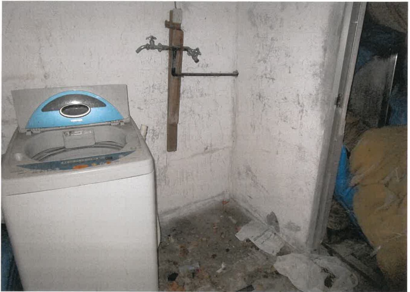
19 附属建物③の入口(西側)
