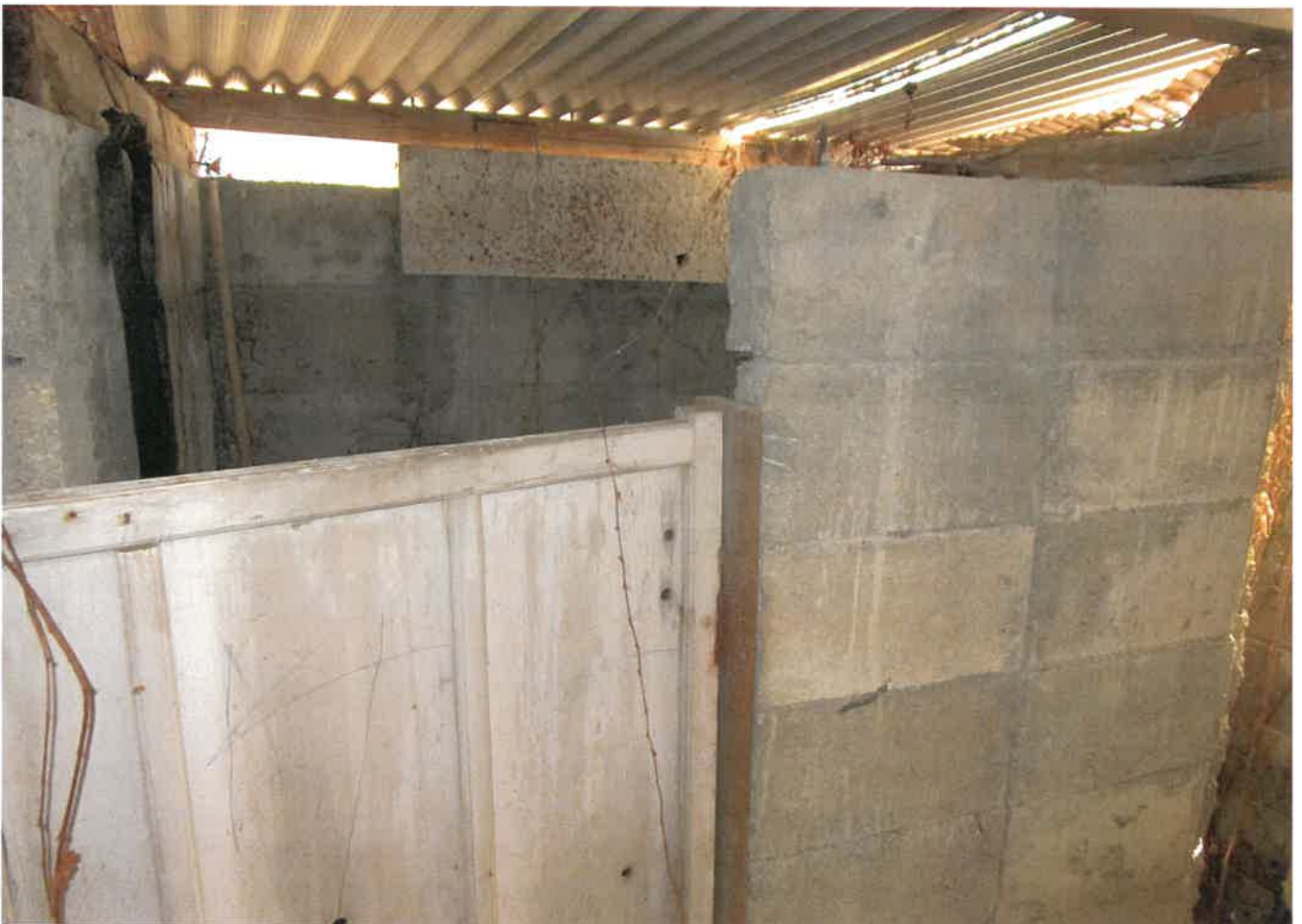
20 附属建物③の東側
