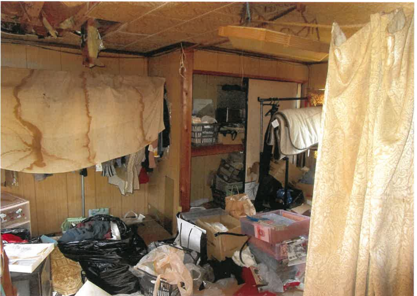
18 附属建物②の2階内部
