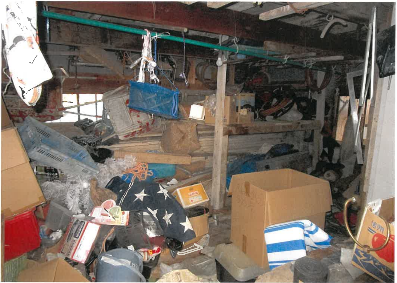
17 附属建物②の1階内部
