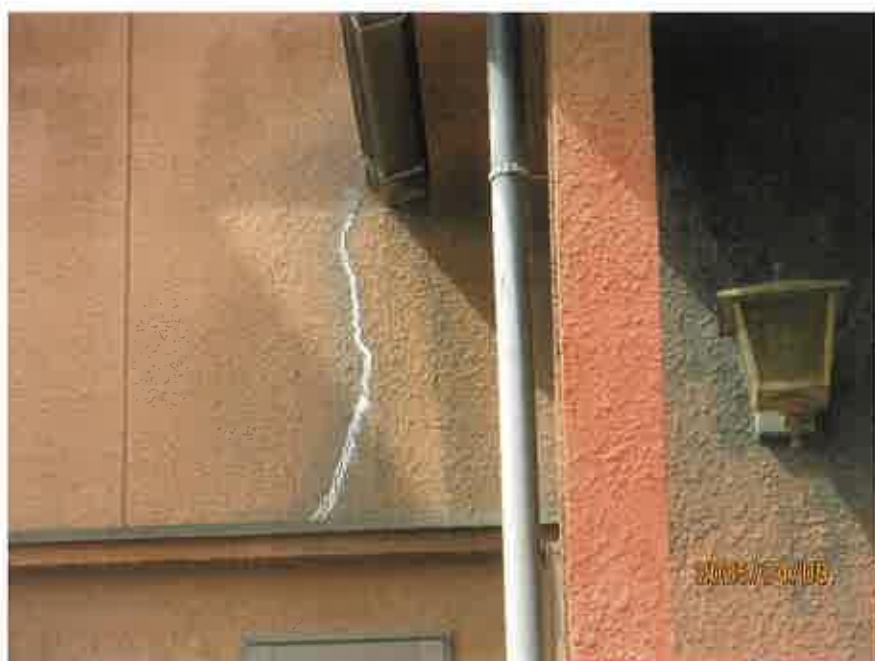
外壁の損傷
