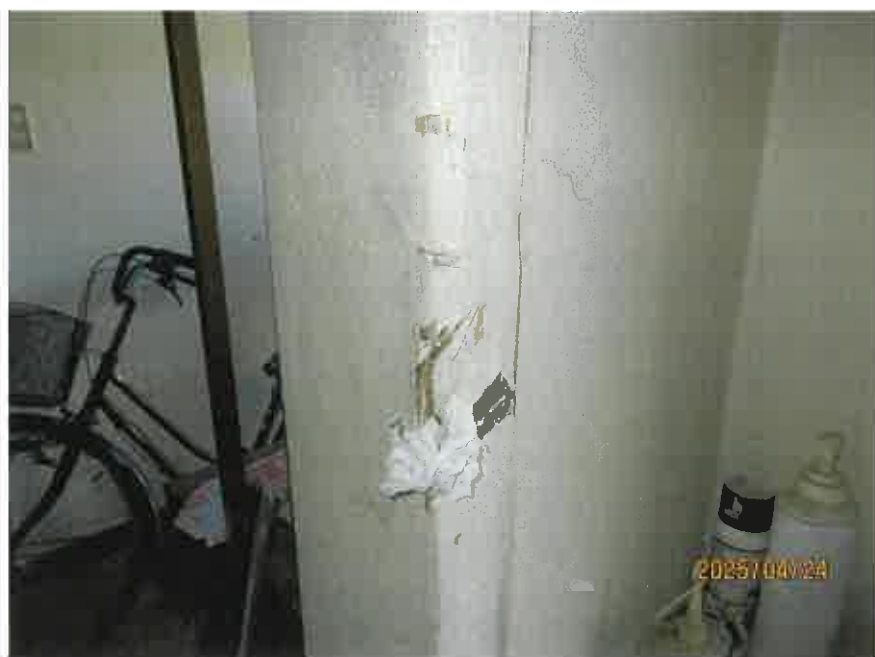
内壁の損傷
