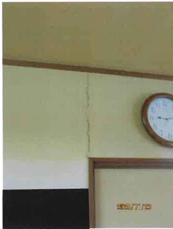
内壁の亀裂 ( 14 枚目 )
