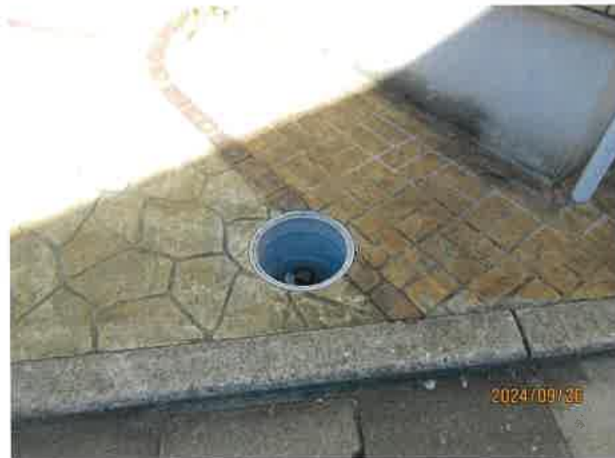
排水柵の蓋の損傷
