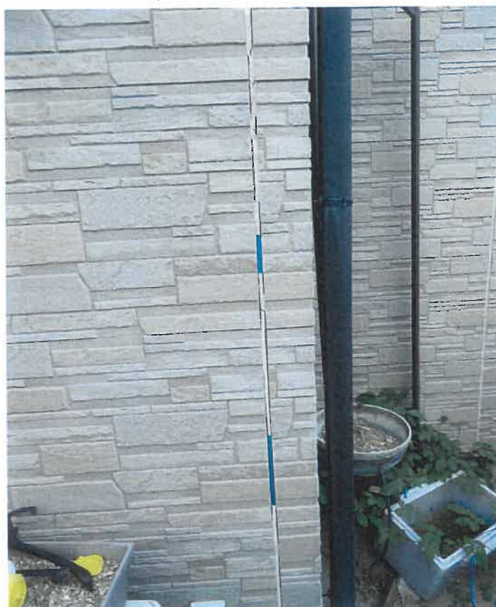
外壁目地のシーリングの剥離等
