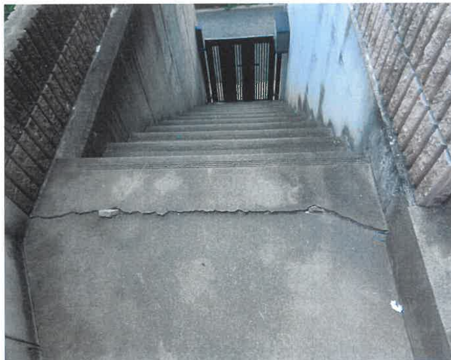
玄関ポーチと外階段の間付近にある亀裂
