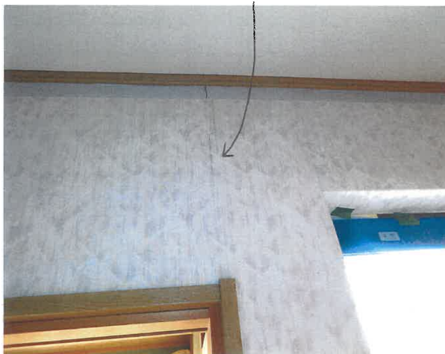
天井付近の壁にある亀裂のような線
