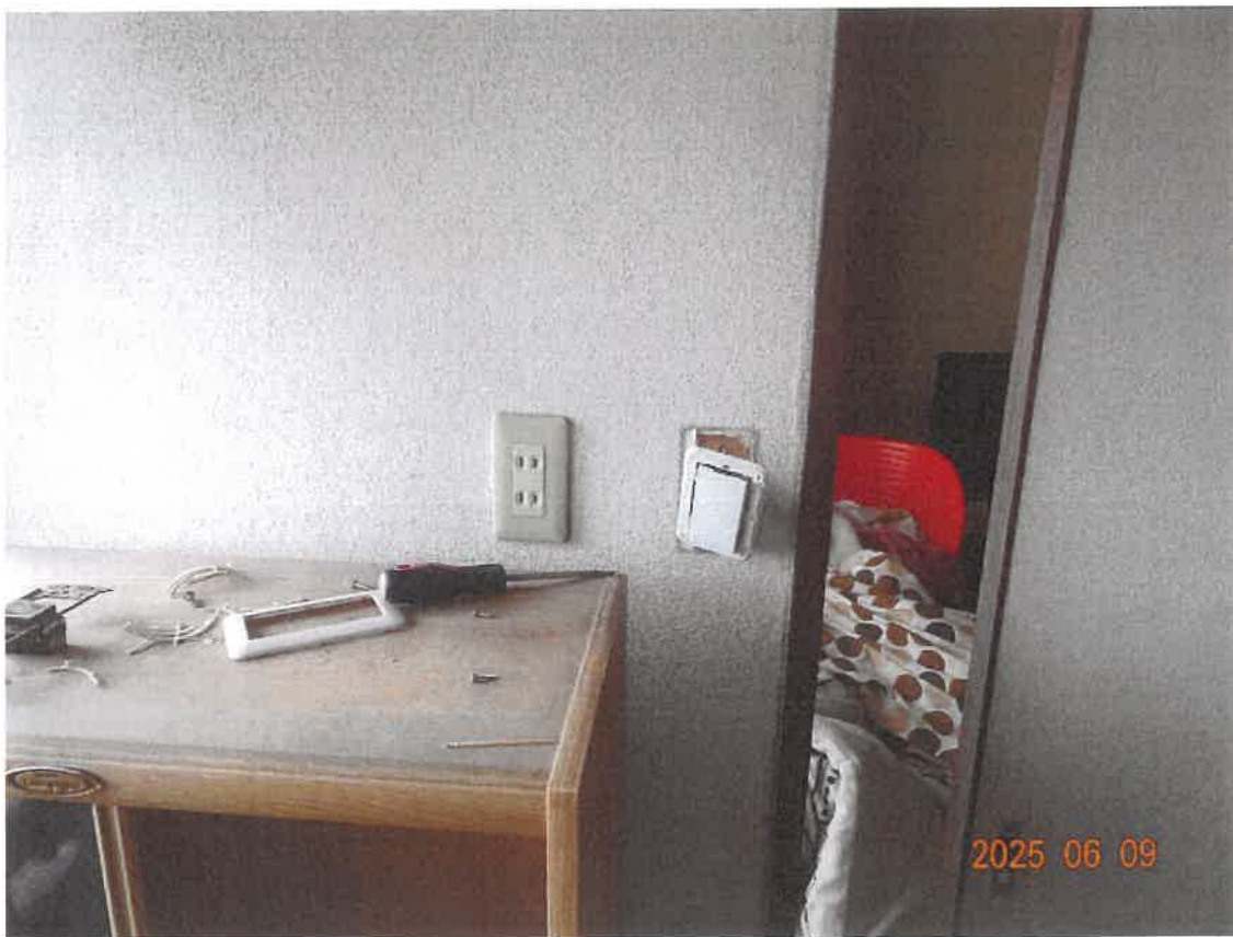
⑩ 3 階スイッチの剥落
