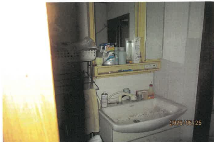
洗面室の状況
