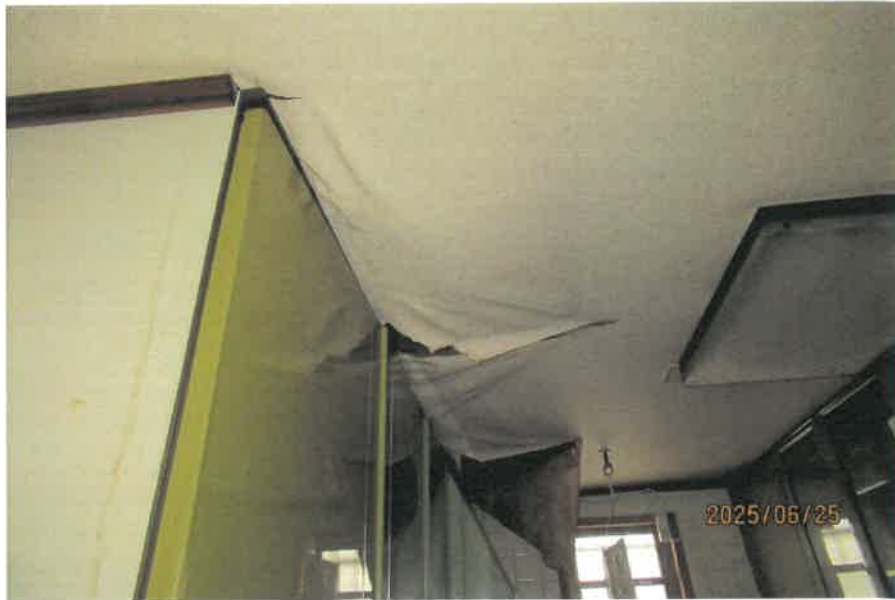
天井クロスが剥離している状況
