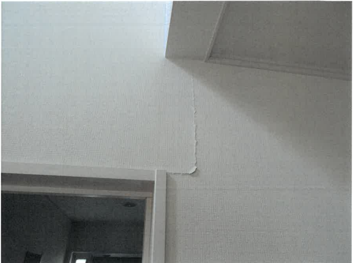
13 壁面のひび割れ
