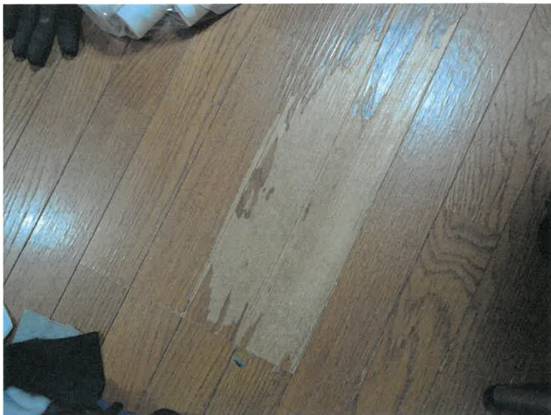
7 床面の損傷
