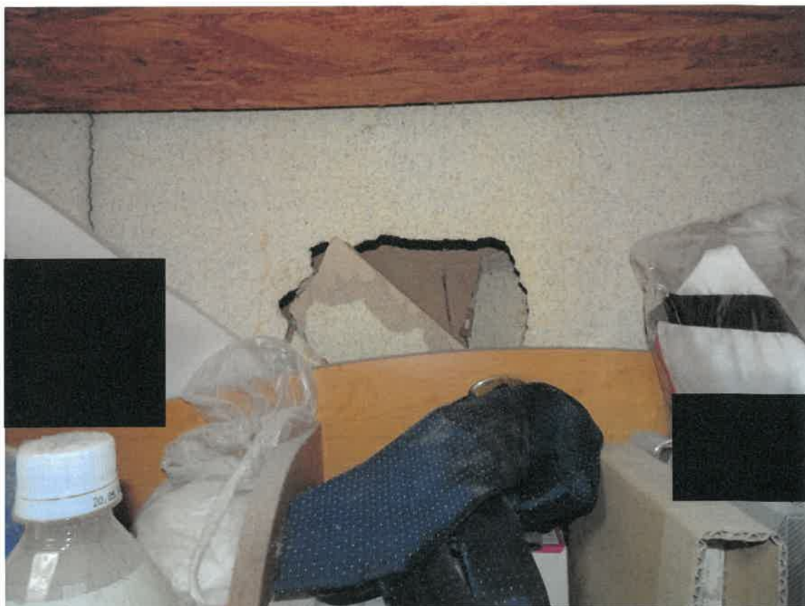
9 壁面の陥没
