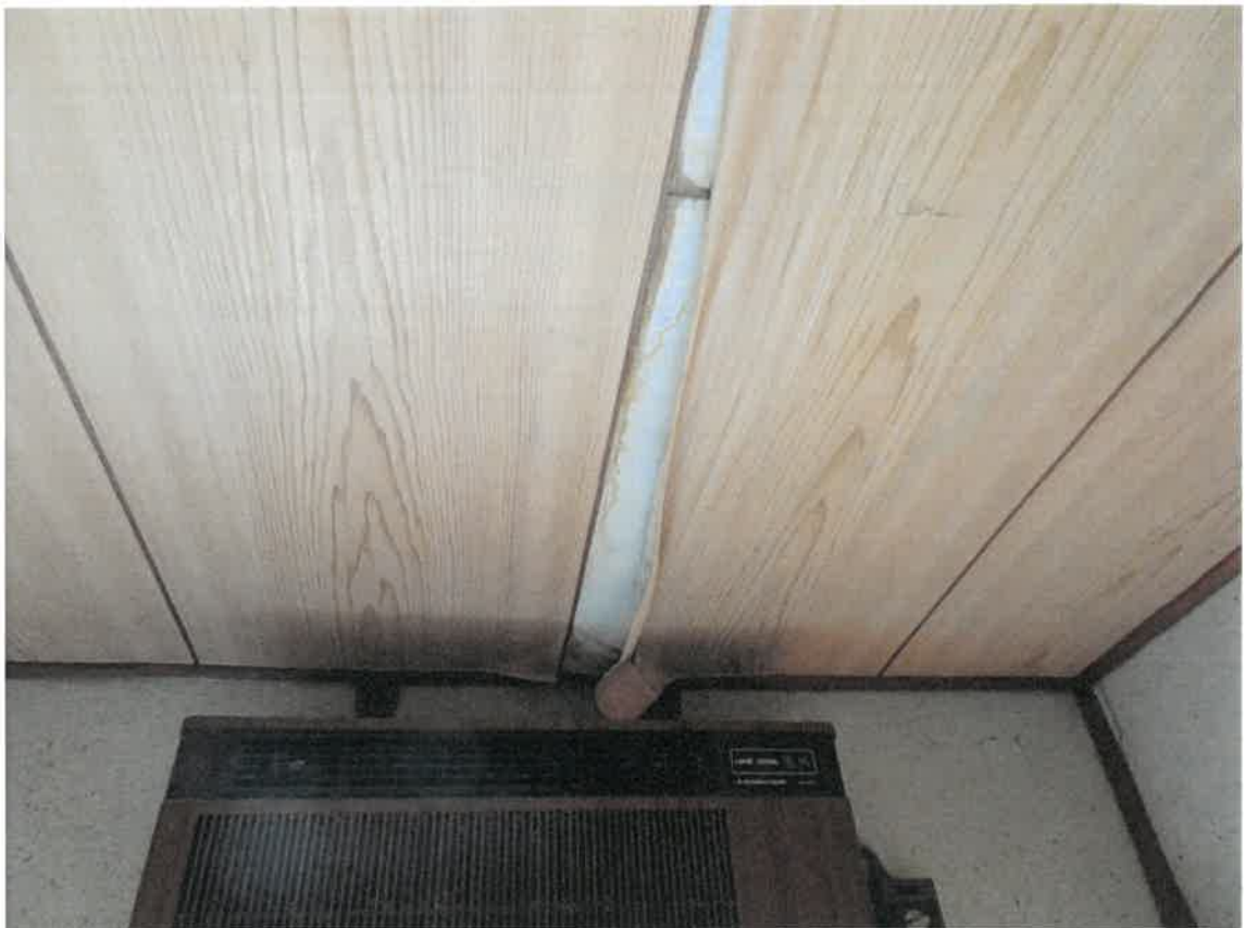
7 天井の雨漏り跡（シミ・剥がれ）
