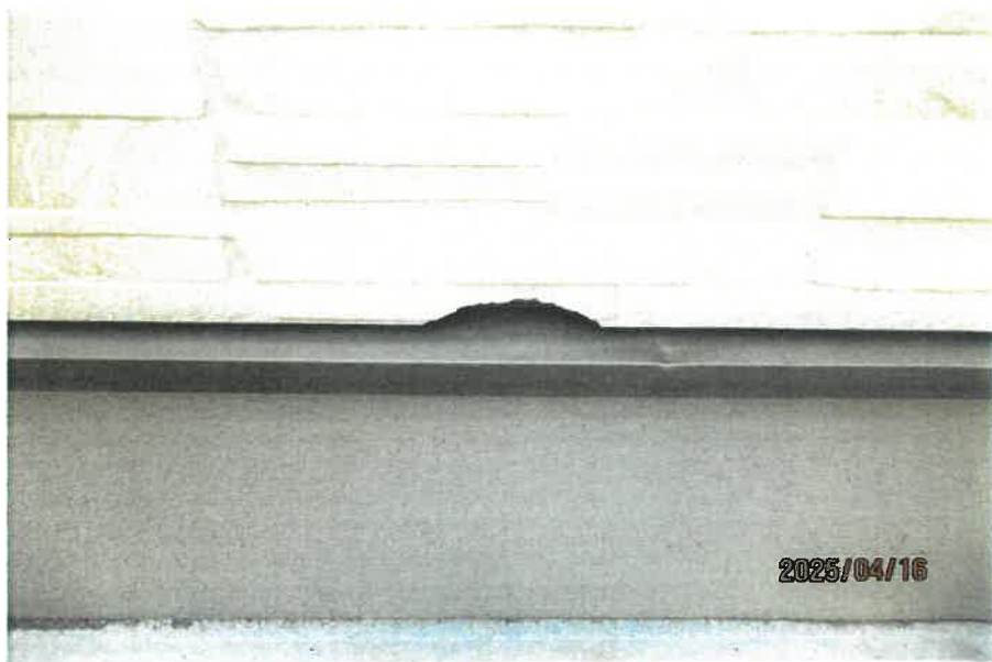
外壁の一部が損傷している状況
