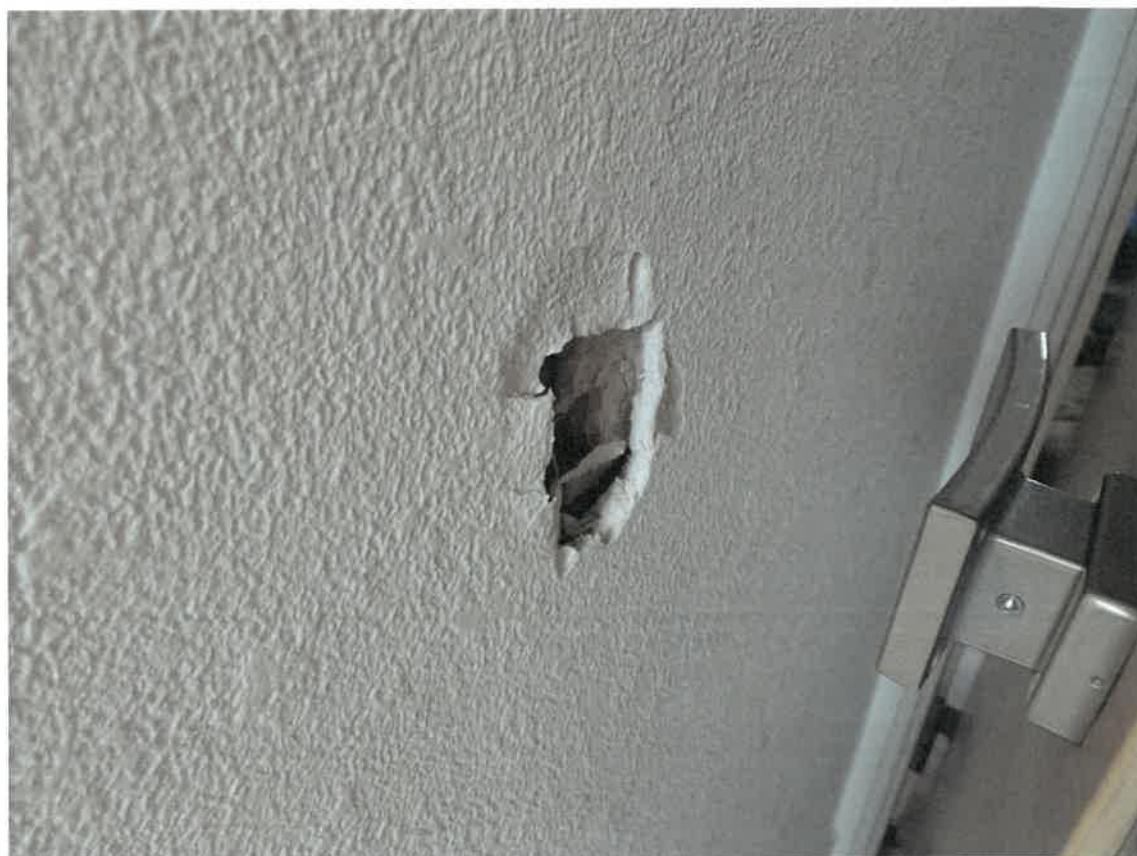
8 壁面の陥没
