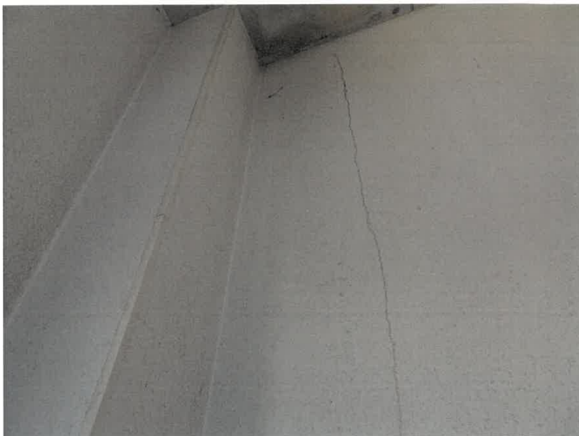
【3階へ至る階段部分】 4 壁面のひび割れ
