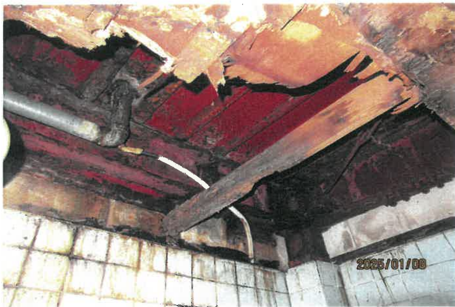
浴室の天井が抜け落ちている状況
