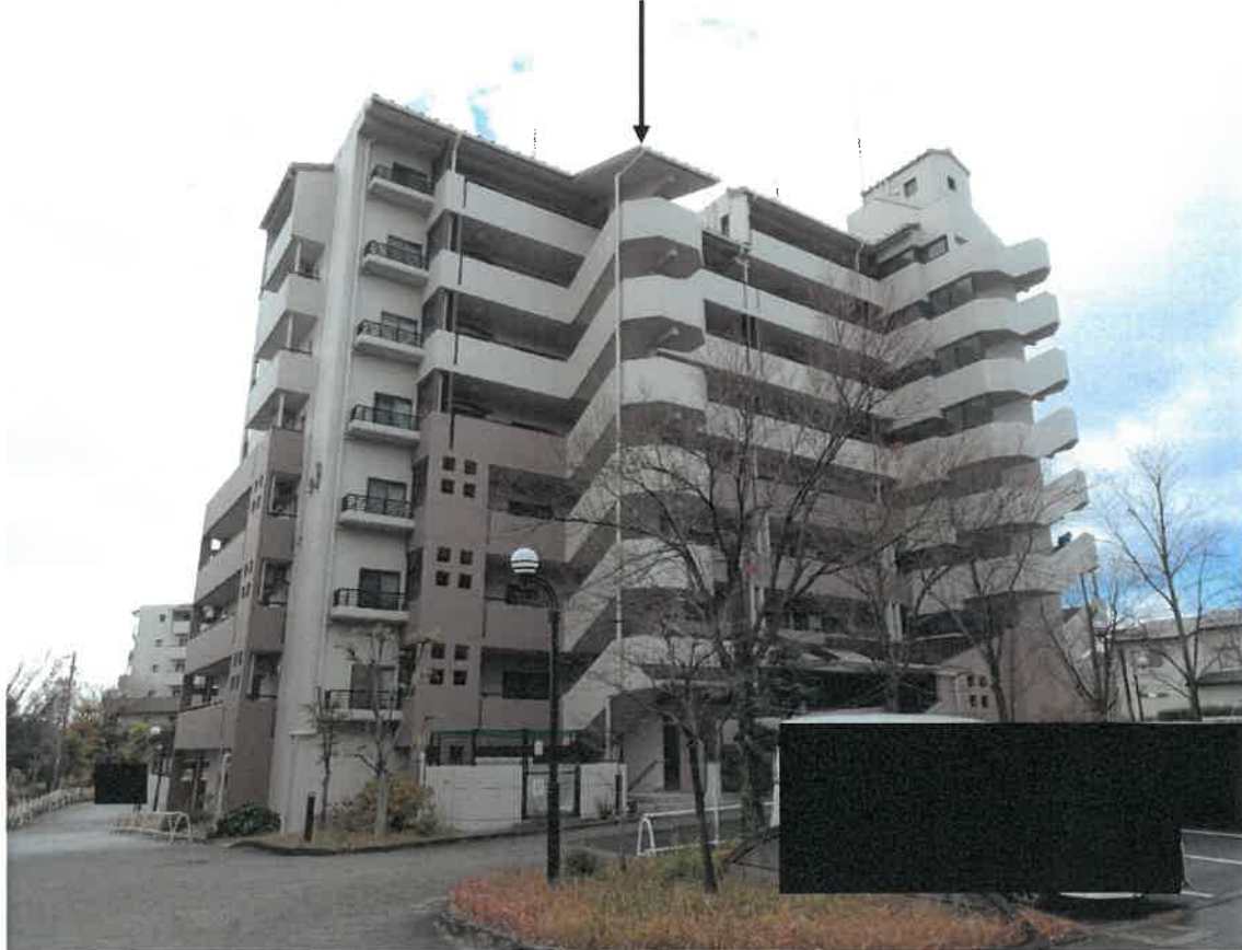
① 目的建物の所在するマンション
