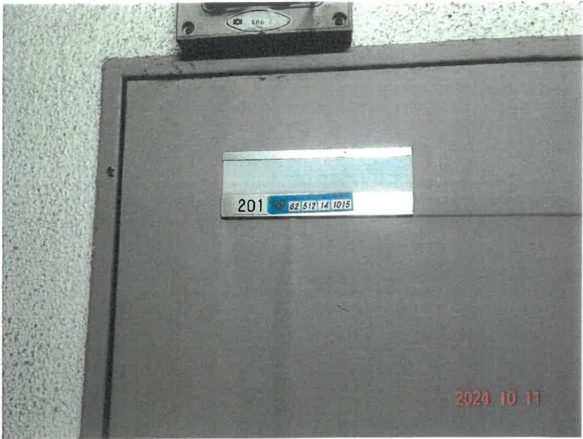
⑭ 浸水によるものと推測される黒ずみ
