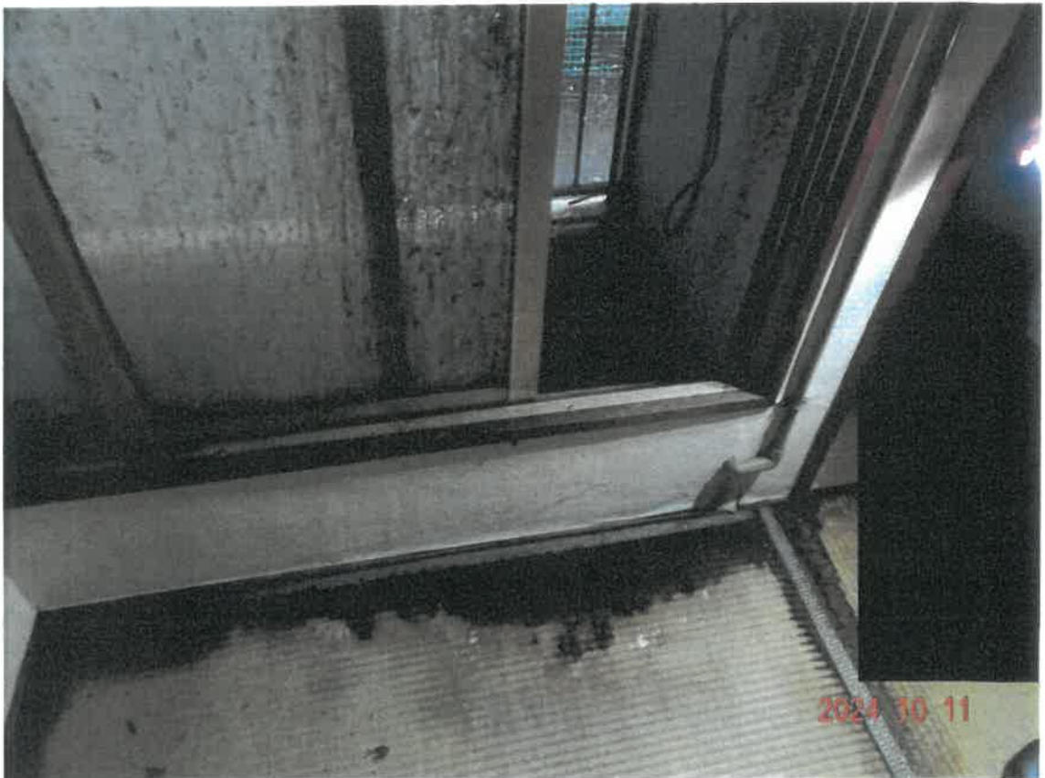
⑭ 浸水によるものと推測される黒ずみ
