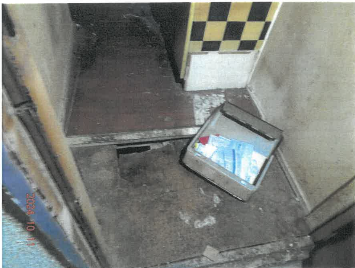
⑫玄関の床の損傷箇所
