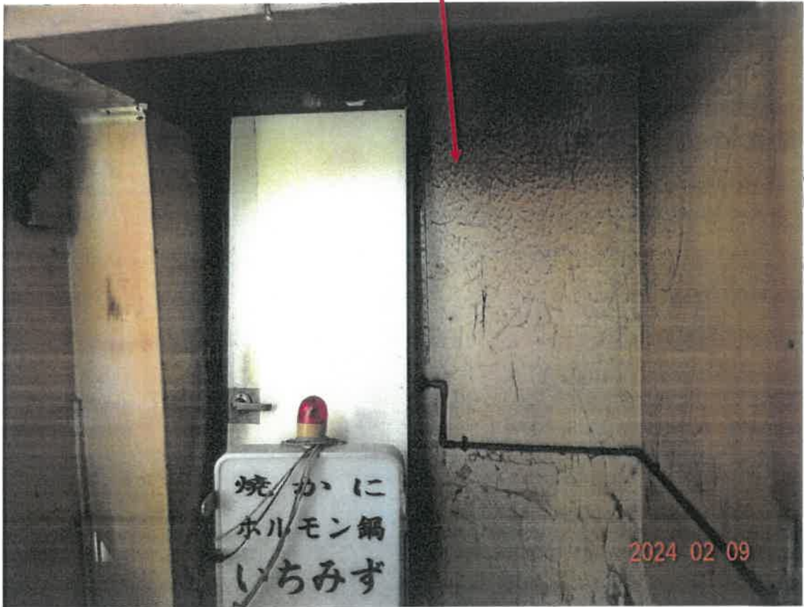
⑤ 1階北側増築部分
