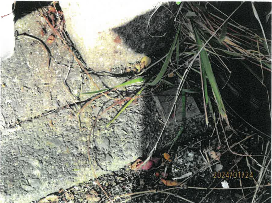
⑥ (南西側隣接地との境界標を 南東側接面道路から撮影)
