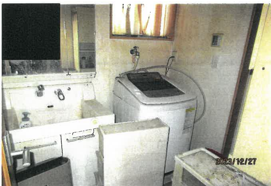
洗面室の状況
