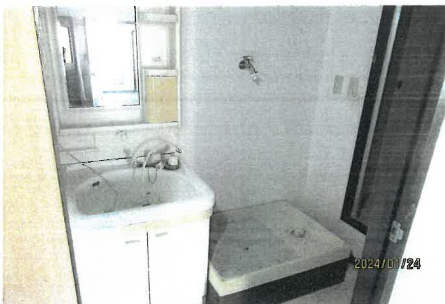
4L号室：洗面室の状況
