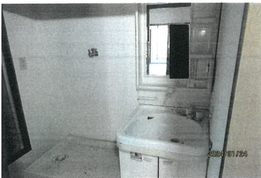
4R号室：洗面室の状況
