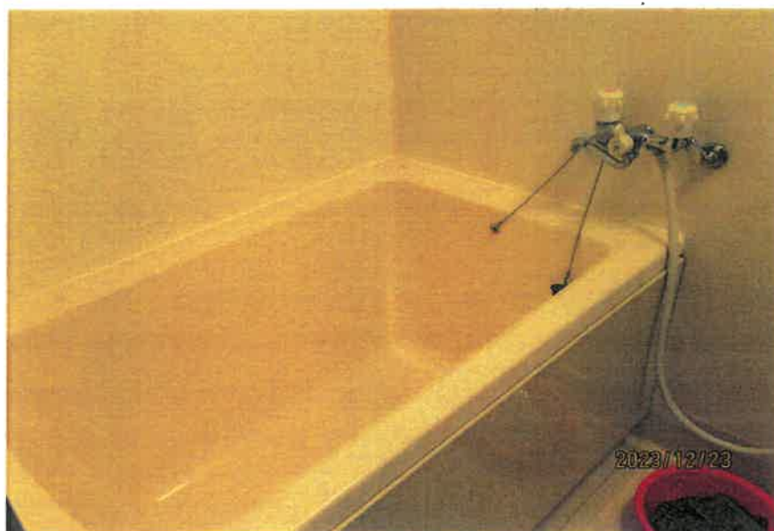
202号室：浴室の状況
