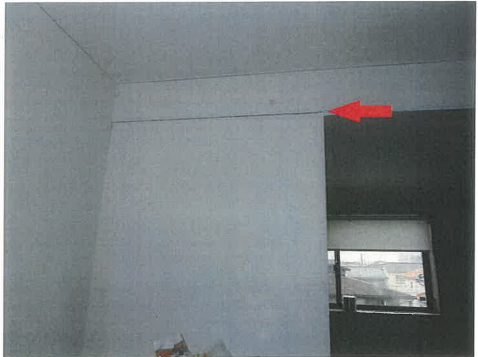
【レンジフード裏の壁のひび割れ（赤矢印）】
