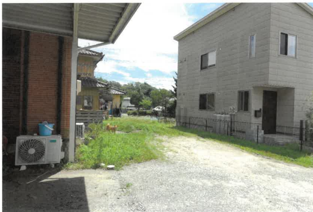
写真④（北西方向から撮影）
