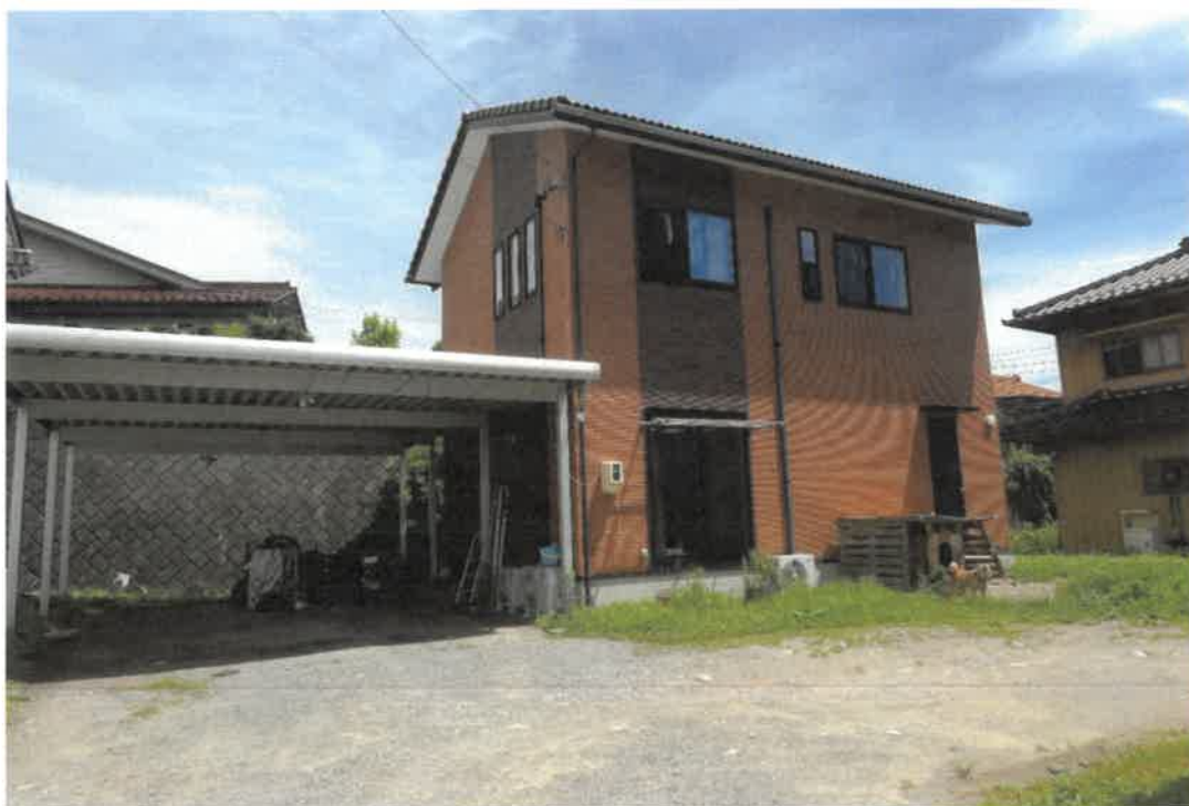
写真③（南西方向から撮影）
