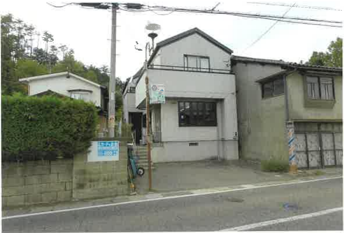
写真①（南東方向から撮影）
