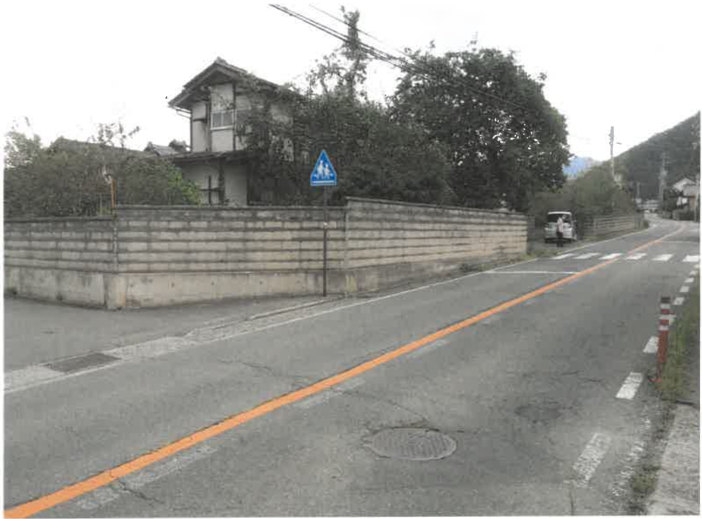
① 西方向から接面道路及び対象不動産全景
