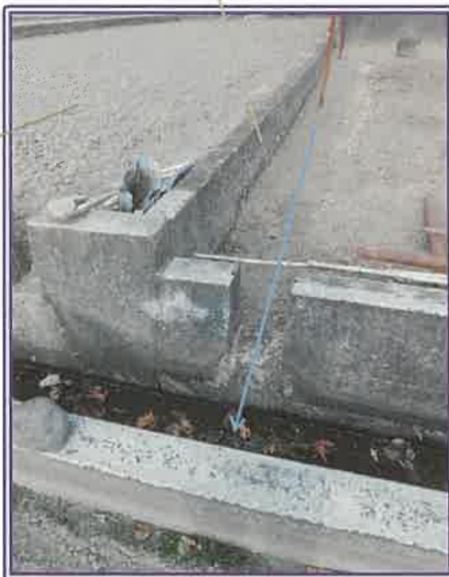
境界線付近の 老朽化したコンクリート製外構
