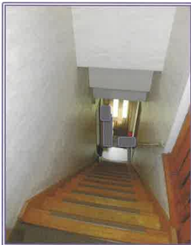
2階 階段【居室内】
