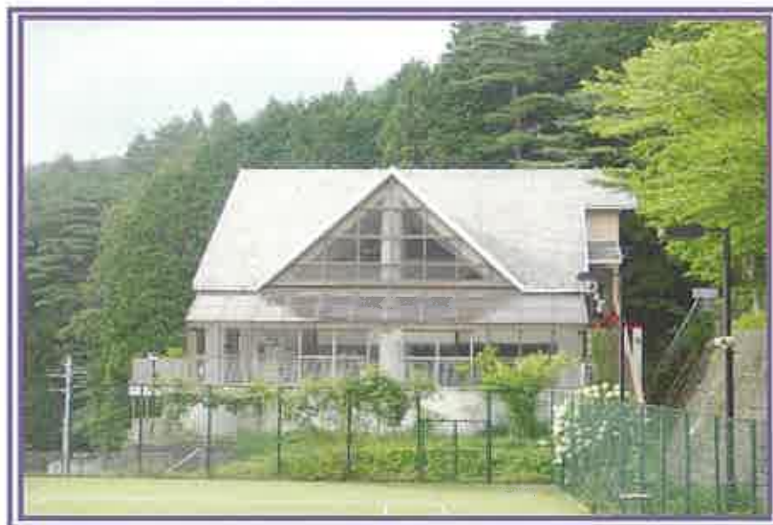
プール棟及びその周辺を撮影したもの
