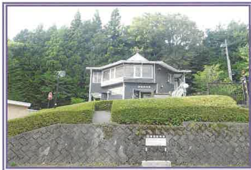
管理棟及びその周辺を撮影したもの
