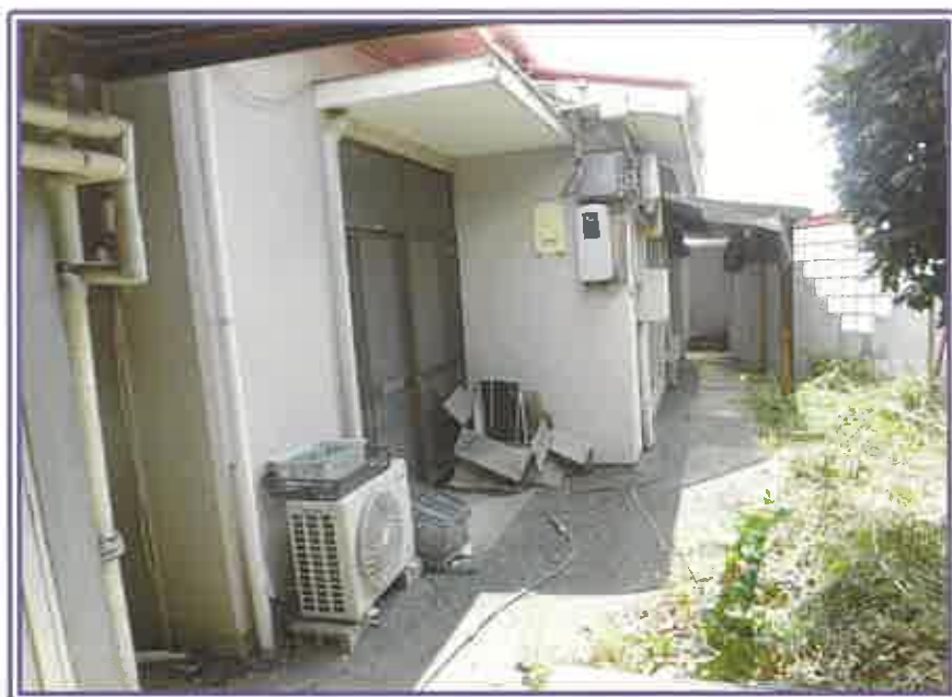
物件8・主たる建物(管理室)の横側近景
