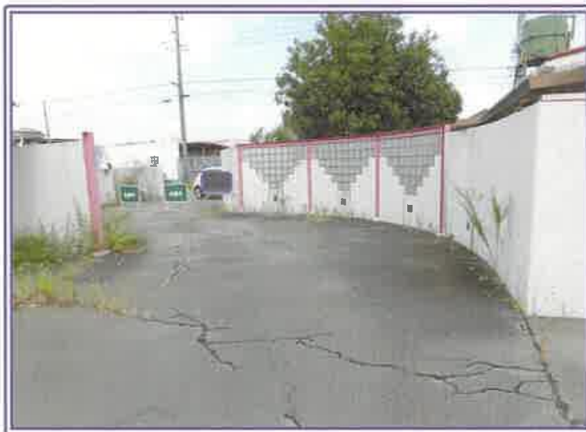
ホテルの出入口付近の状況
