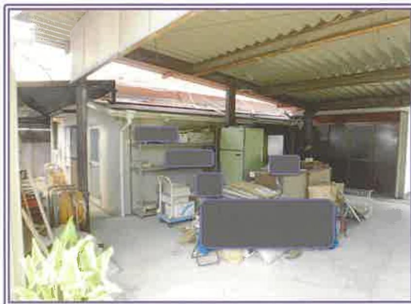
物件8・主たる建物（管理室・左）と未登記附属建物2（物置・右）
