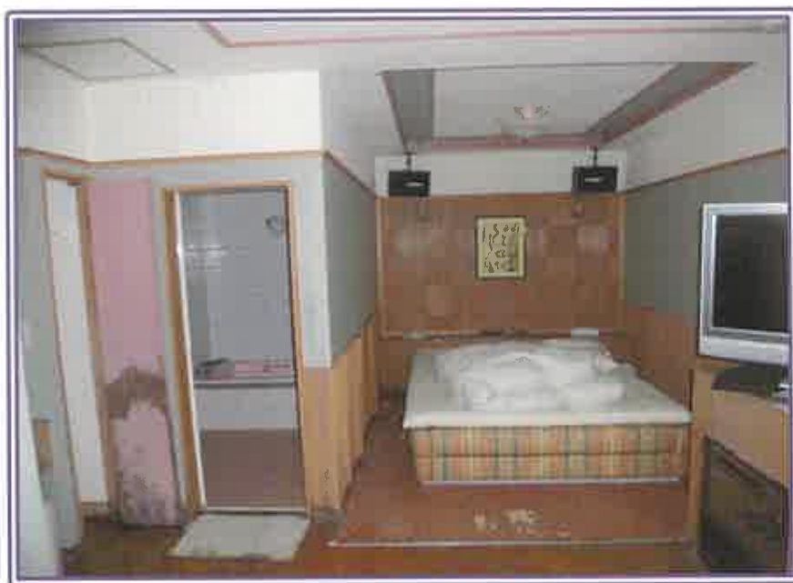
レストルーム / 物件7 既登記（符号1～3）附属建物（旅館（ラブホテルの個室））
