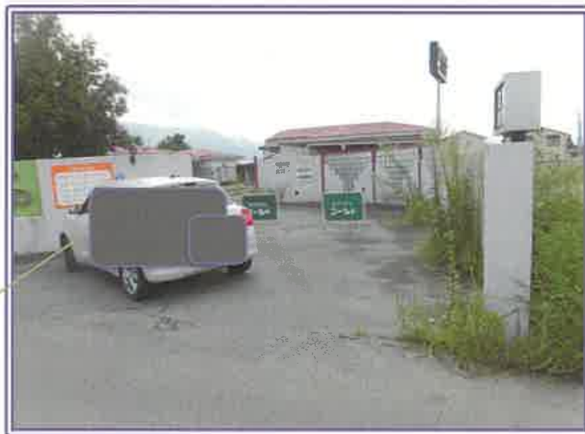
ホテルの出入口付近の状況
