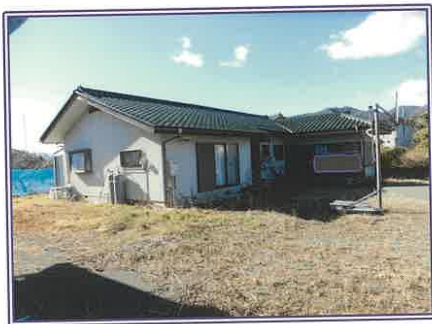
物件4の居宅の表側全景
