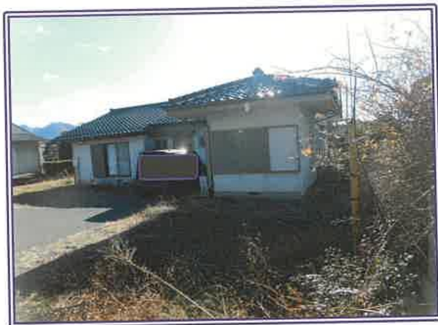
物件4の居宅の表側全景
