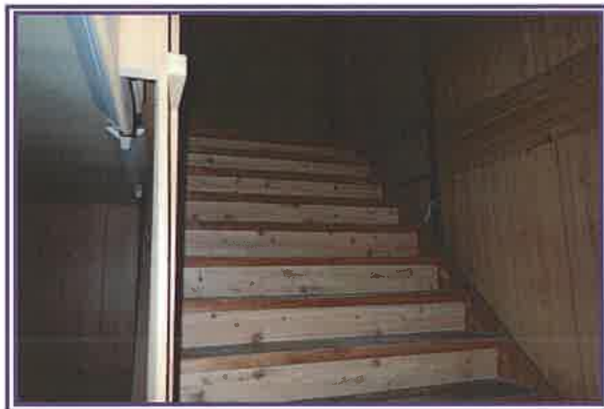
1階から、階段方向を撮影したもの(物件2附属建物符号1)
