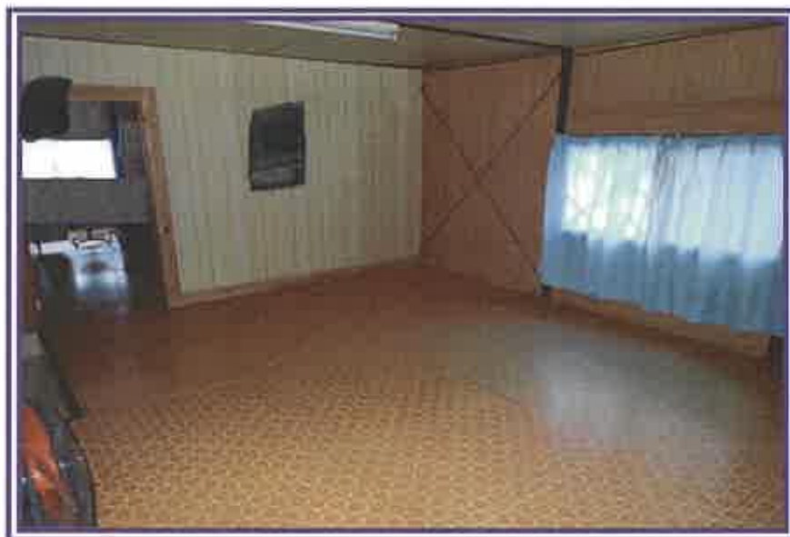
2階倉庫1 (物件2附属建物符号1)
