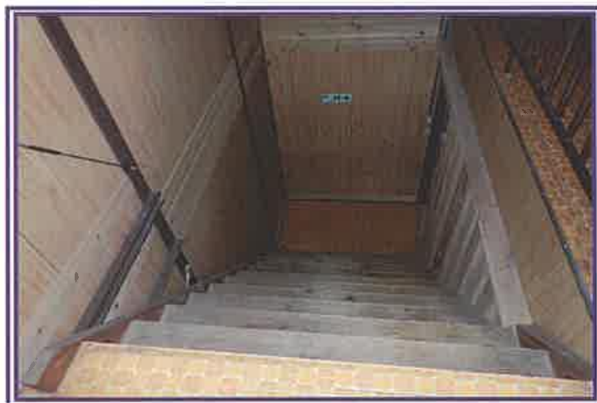
2階から、階段方向を撮影したもの(物件2附属建物符号1)
