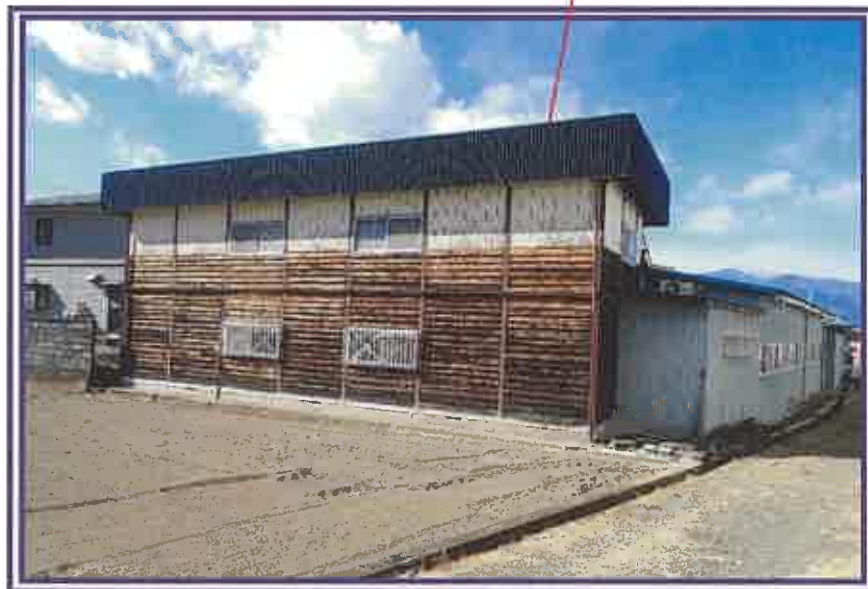
物件2(工場) 附属建物符号1 増築部分
