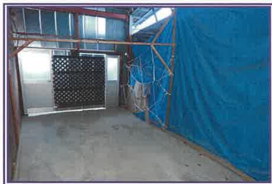
ビニールシートと壁で囲まれている箇所を撮影したもの (物件2附属建物符号1)
