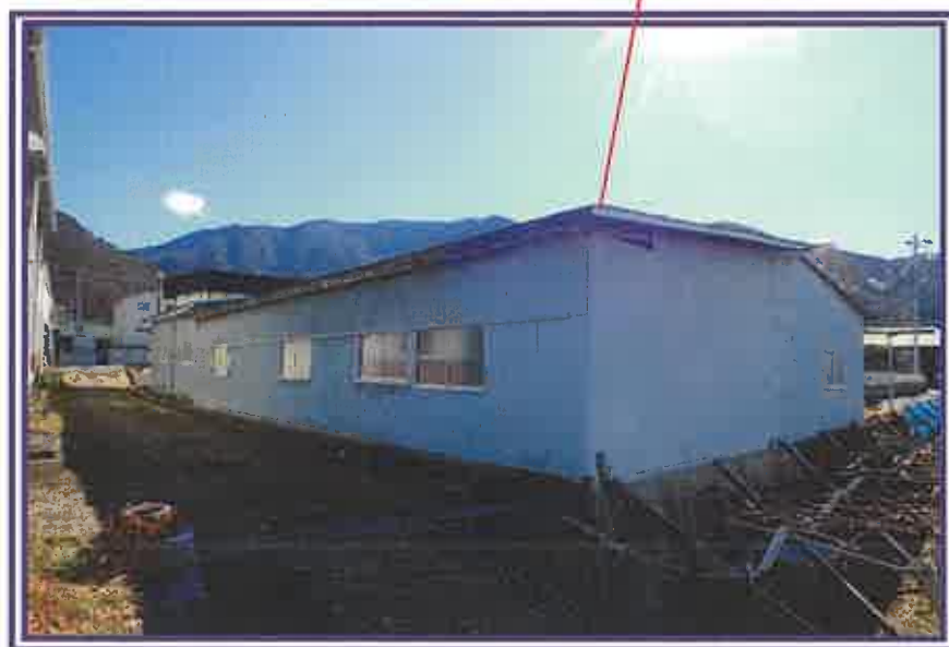
物件2(工場) 主である建物
