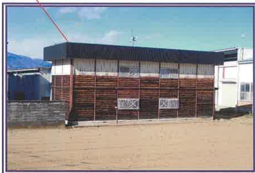
物件2附属建物符号1増築部分及びその周辺を撮影したもの(拡大撮影)
