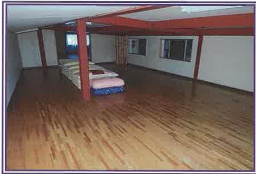
2階倉庫2 (物件2附属建物符号1)
