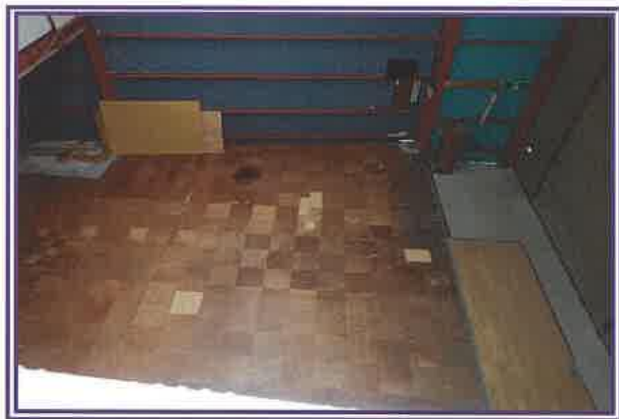
2階倉庫2から、1階作業室4方向を撮影したもの (物件2附属建物符号1)
