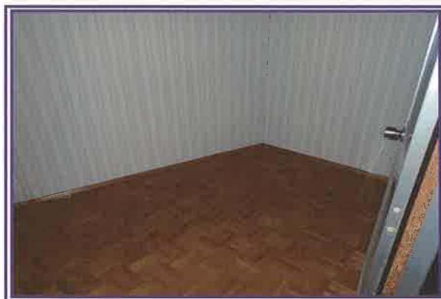
1階休憩室 (物件2附属建物符号1)
