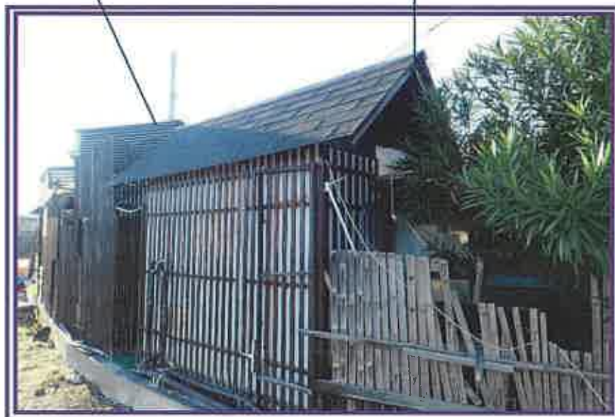
調理室, 食堂 (売却対象外の 未登記附属建物4)
