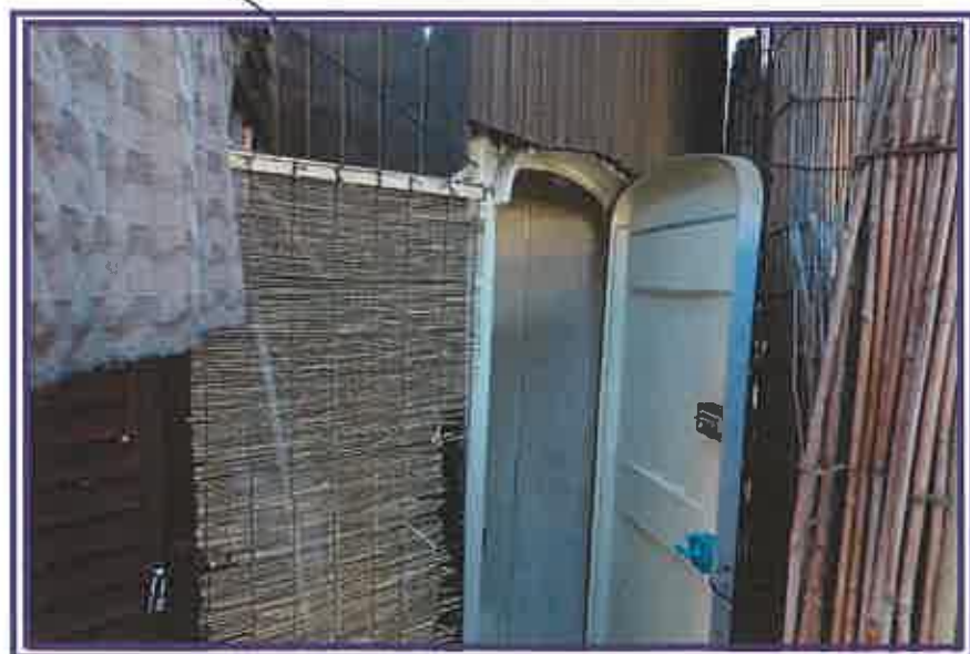
トイレ及びその周辺を撮影したもの
