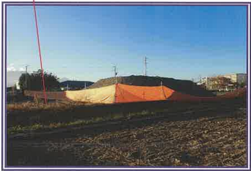
物件2の土地の中間ぐらいに幕が設置されていた状況を撮影したもの
