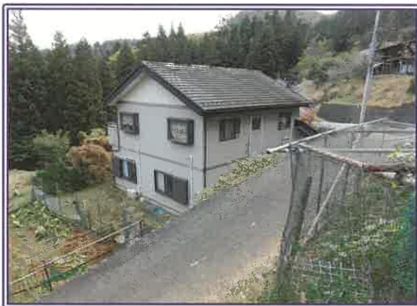
物件3の居宅の側面（大月市の管理する法定外道路）側全景
