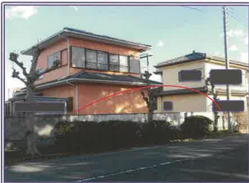
物件2の居宅の真側全景（手前は西側市道）
