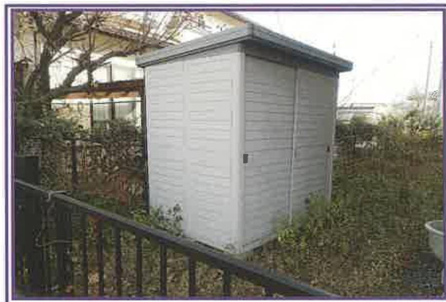
物置(北側)及びその周辺を撮影したもの
