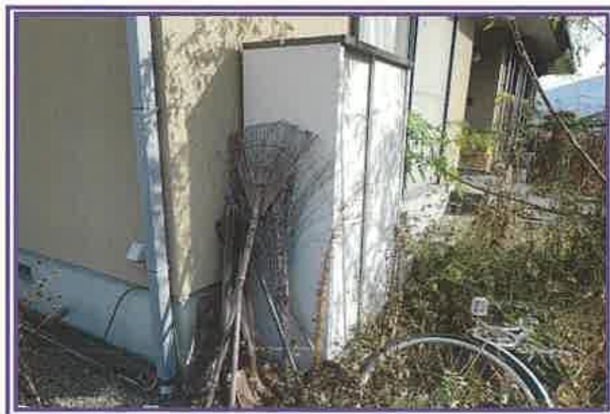
物置(南側)及びその周辺を撮影したもの
