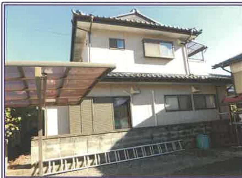
物件3の居宅の裏側近景（塀の手前は隣地（231-16・231-18））
