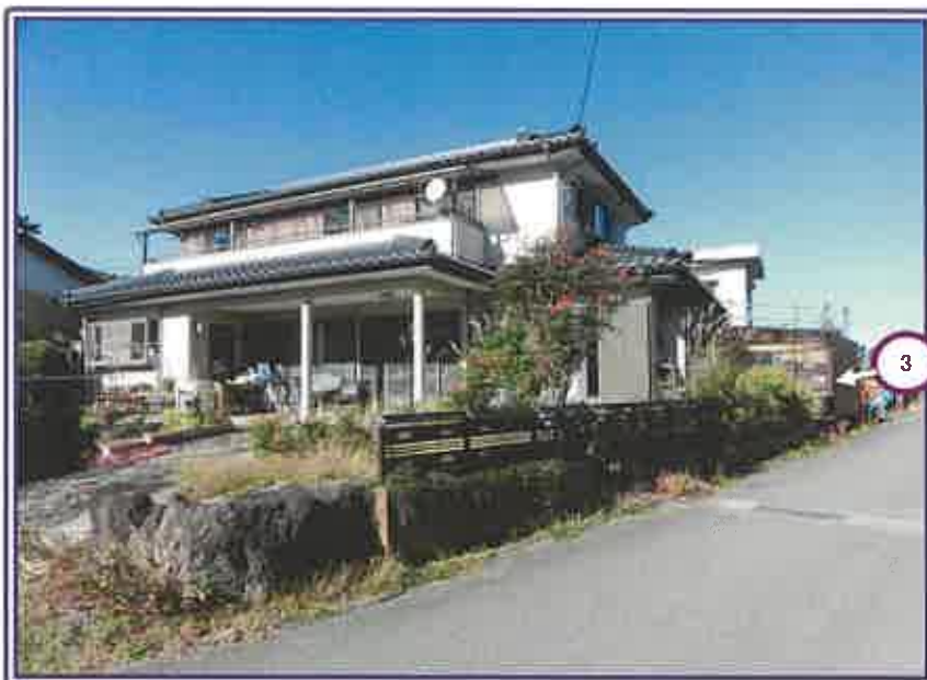
物件3の居宅の町道側近景
