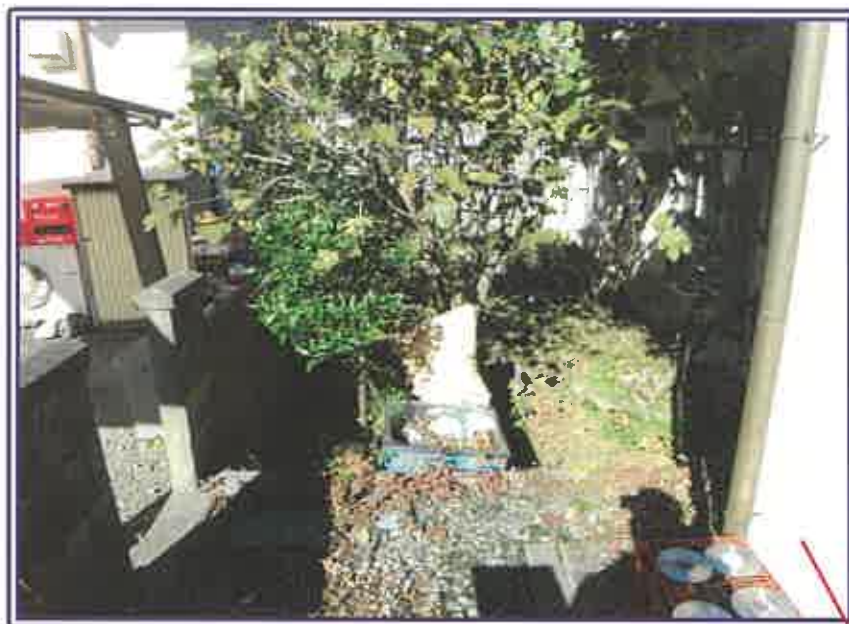
北西角境界付近の状況
