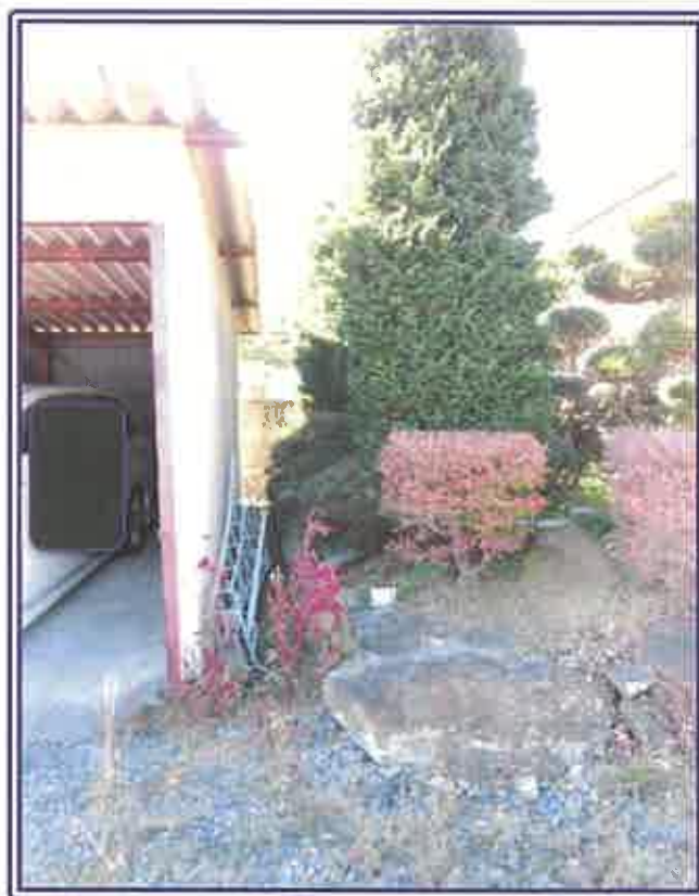
左側の売却対象外の隣地（車庫の敷地・231-28）との境界が不明確 ※ 本件土地所有者からの確認によると奥まで伸びている石垣付近が 大凡の境界である模様
