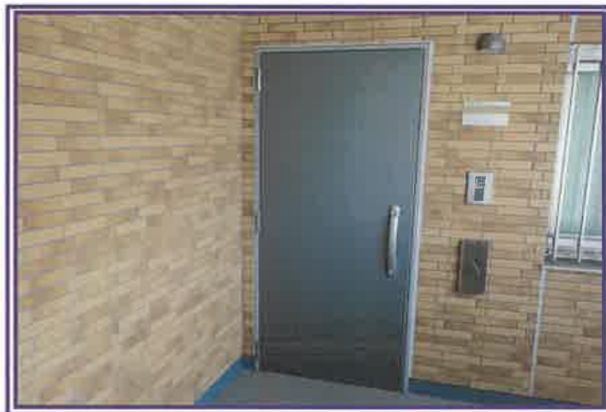
1002号室の入口付近を撮影したもの
