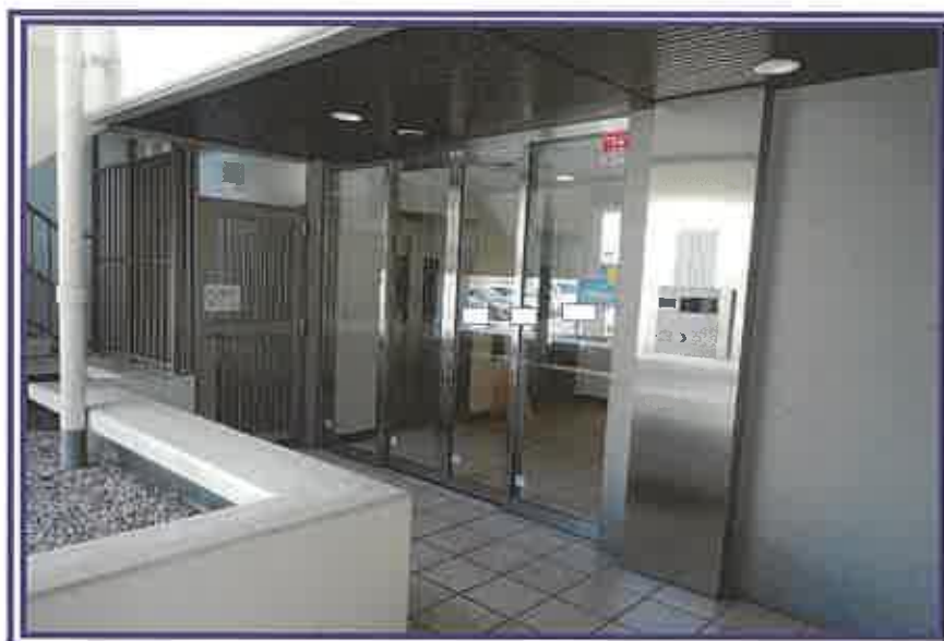
エントランス(サブ)付近を撮影したもの
