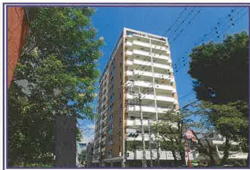
物件1の区分所有建物(1002号室)を含む一棟の建物 (ダイアパレス甲府丸の内)
