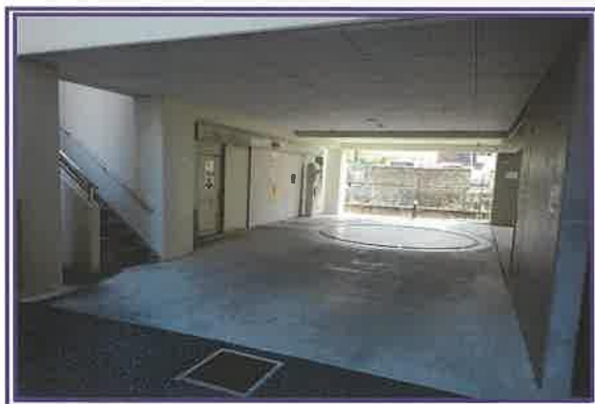
立体駐車場の入口付近を撮影したもの
