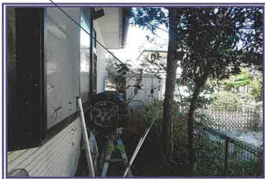
物置1及びその周辺を撮影したもの
