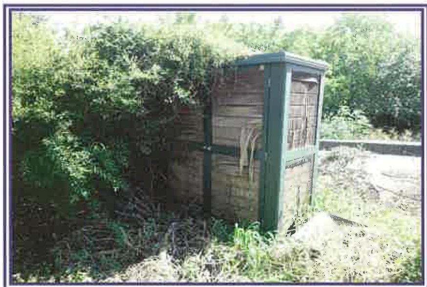
物置2及びその周辺を撮影したもの
