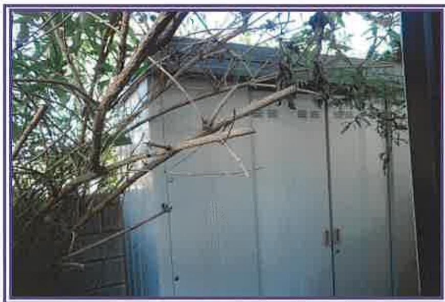
物置1及びその周辺を撮影したもの
